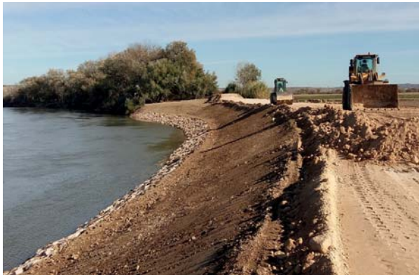
Reparación y acondicionamiento de mota en Osera de Ebro (Zaragoza)
