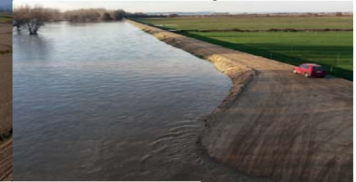
Retranqueo mota Alfaro (La Rioja) Longitud: 710 m
