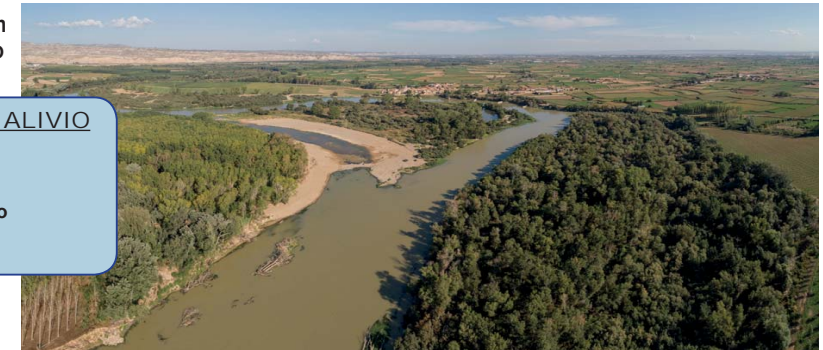
Cauce de alivio Alcalá de Ebro (Zaragoza)
