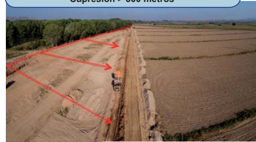
Retranqueo mota Alfaro (La Rioja) Longitud: 710 m
