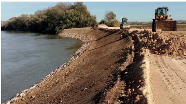
Reparación y acondicionamiento de mota en Osera de Ebro (Zaragoza)
