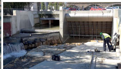
Instalación de compuertas flotantes río Queiles Tudela (NA)
