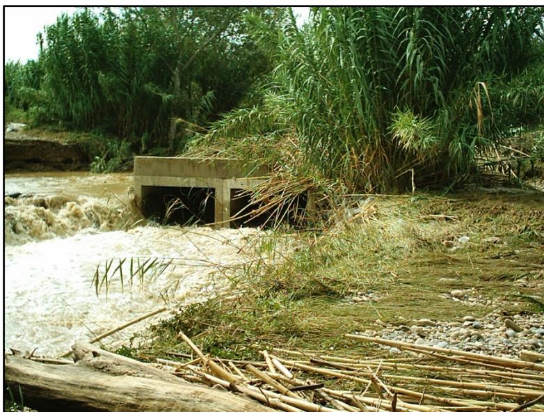
Figura 3. Puente de "El Gato" en Novillas, instantes antes de ser arrastrado por las aguas (Confederación Hidrográfica del Ebro).
